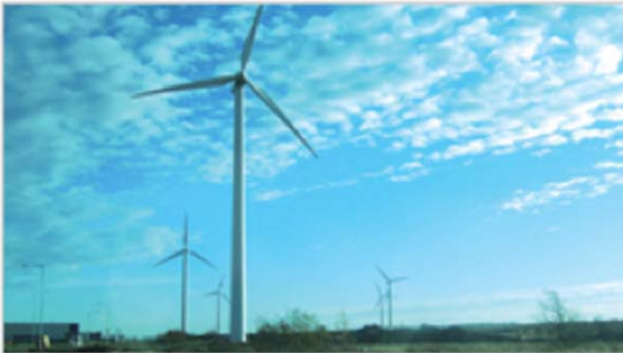
英国日産自動車製造会社は、2005年から工場内に風力発電を導入。
