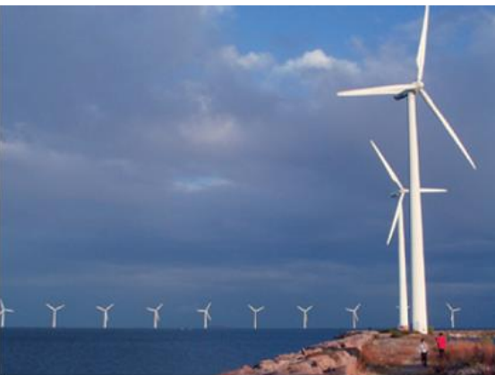
デンマーク・コペンハーゲン沿岸の洋上風力発電所
