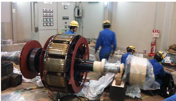
分解部品最大級の回転子（約8t）分解手入れ
