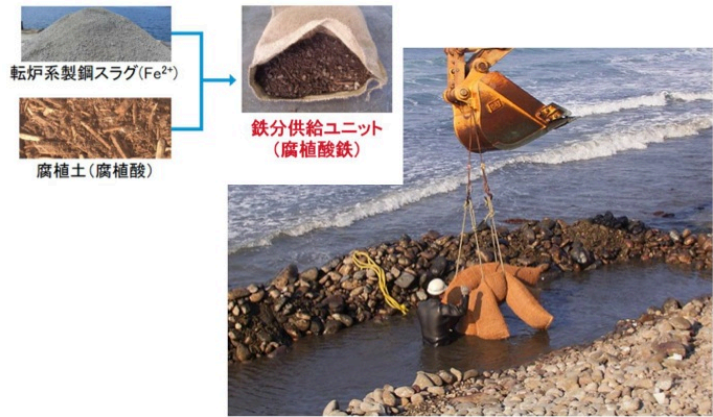
写真3 鉄分供給ユニット施工状況 (平成16年10月)
