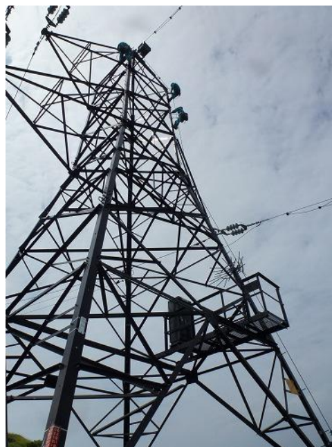
高さ26mの鉄塔の上での作業が続く。
