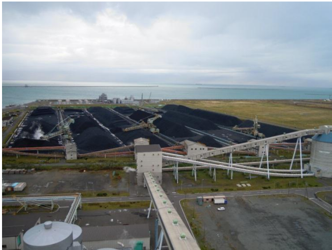
写真2：広大な貯炭場。苫東厚真火力では1日1万5千トンの石炭を消費する。 この日もオーストラリアからの運搬船が着岸していた。
