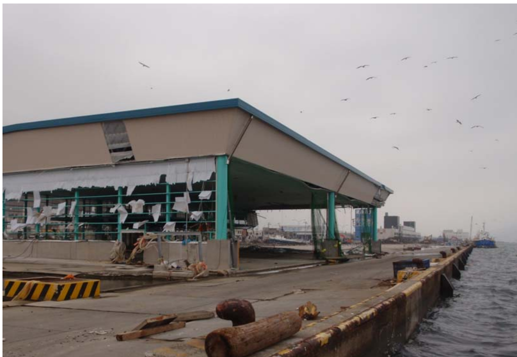
石巻の漁港の様子(長さ 652m の上屋根のあった魚市場付近。津波被害を受け、解体・撤去が進む)
