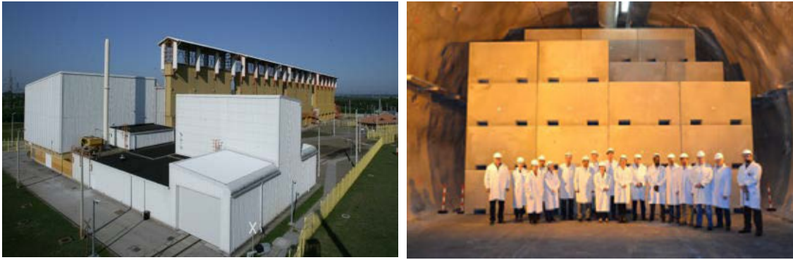
使用済燃料の中間貯蔵施設（左）と低中レベル放射性廃棄物処理施設（右）（写真出典：ハンガリー側資料より）
