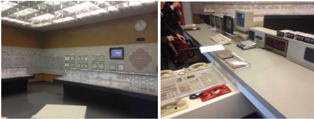
ツヴェンテンドルフ原子力発電所の中央制御室（写真は筆者撮影）
