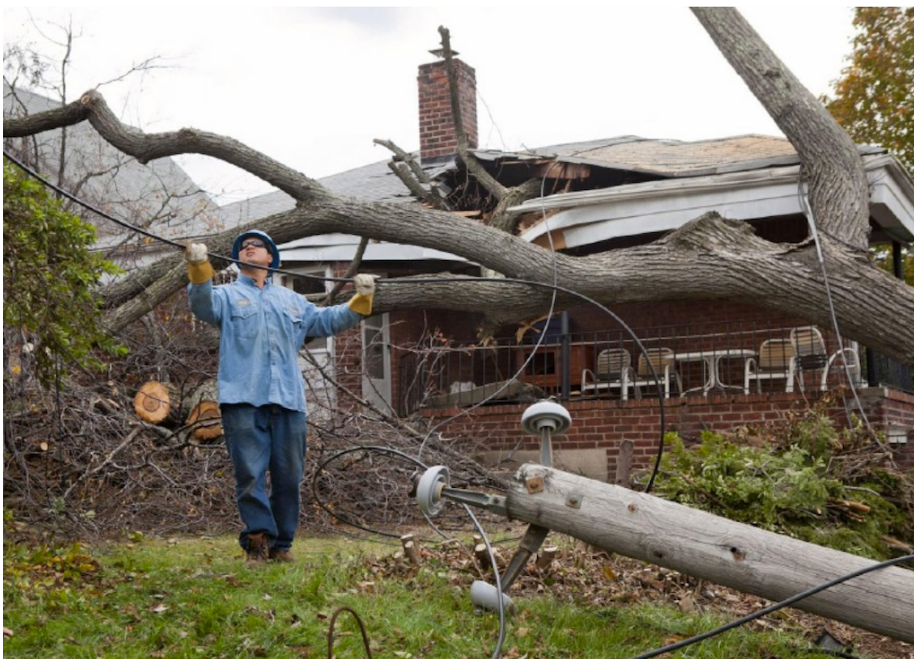
図 3. 倒木により倒壊した配電設備の復旧にあたる作業員（コン・エジソン社）
