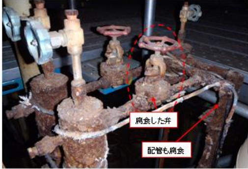
循環水ポンプ点検架台 台座部鋼材の腐食
