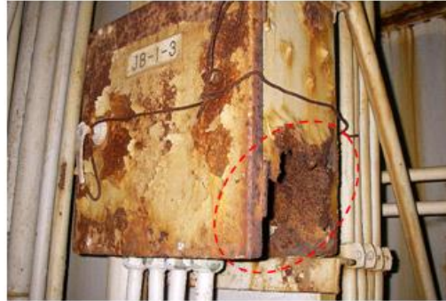
現地端子箱の腐食(穴開き)
