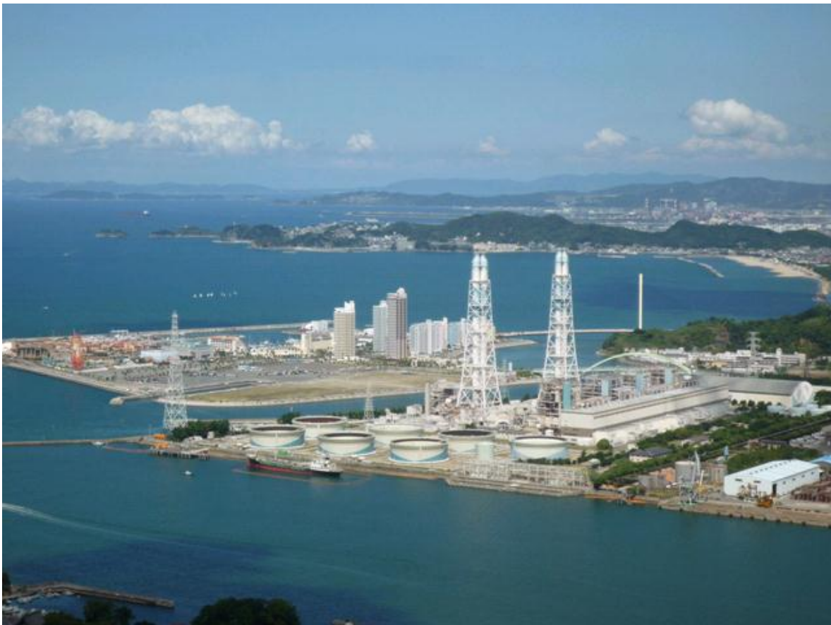
海南発電所全景
