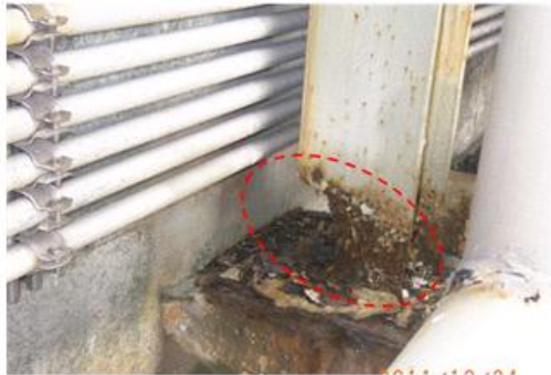
循環水ポンプ点検架台 台座部鋼材の腐食
