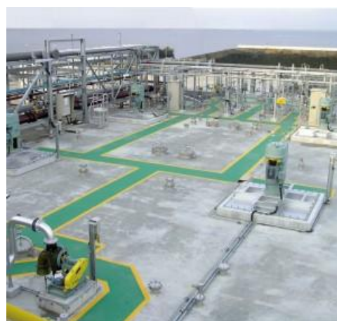
【密閉型排水処理設備】野中さんご自慢の密閉型排水処理設備。「通常の開放式排水処理設備だとしてもにおいができます。でもお父さんの働く工場を見に来た子どもさんに『臭い』といわれたらせつない。会社にながまを言って導入してもらいました」と語る笑顔は、まさに働くお父さん！
